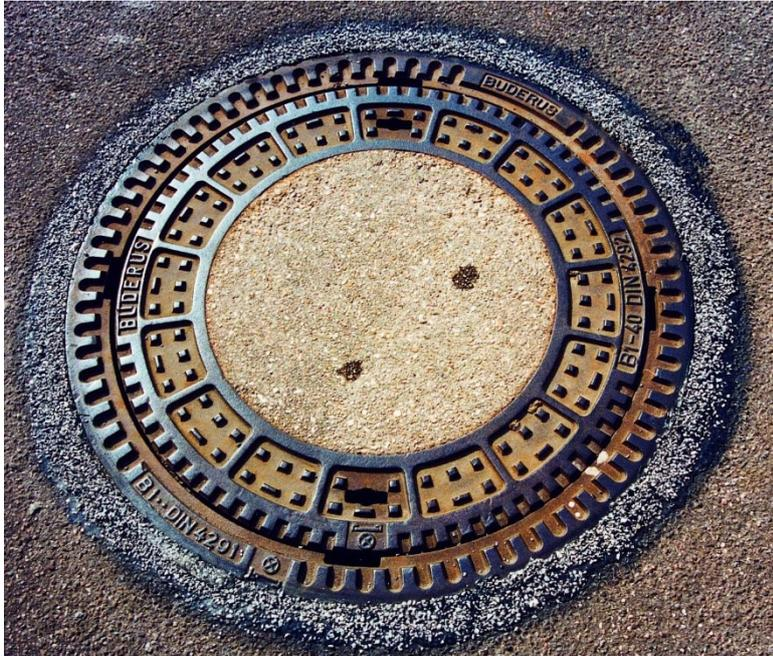
Im Vergleich zur konventionellen Sanierung mittels Tiefbau zeichnet sich das Verfahren insbesondere durch Langlebigkeit, Kosten und der Tatsache, dass die Sanierung meist ohne Vollsperrung erfolgen kann, aus. Für einen sanierten Schachtdeckel kann bei diesem Verfahren mit finanziellen Aufwendungen von max. 2.000 € gerechnet werden, insbesondere dann, wenn auch die Schachtabdeckung zu ersetzen ist. Kann der Schachtdeckel weiter verwendet werden, so liegen die Aufwendungen meistens und 1.000 €.
